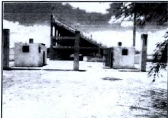
FOTO Nº 4 CONSTRUÇÃO DE BILHETERIA DA ENTRADA DE VISITANTES - ESTÁDIO DOMINGÃO DATA ABRIL / 2017
