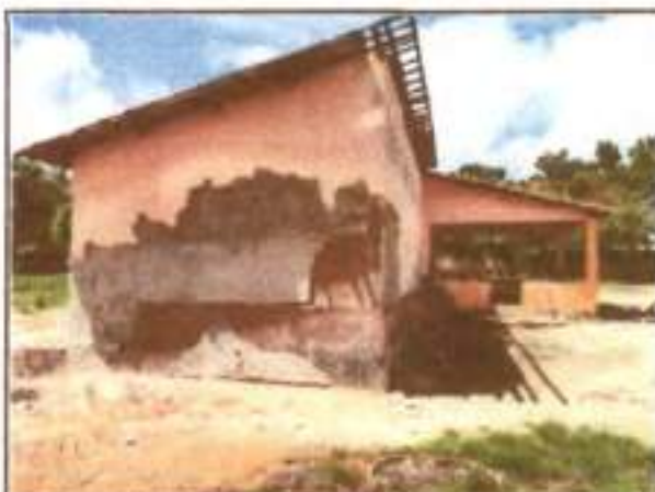
FOTO Nº VISTA LATERAL SALGADEIRAS
