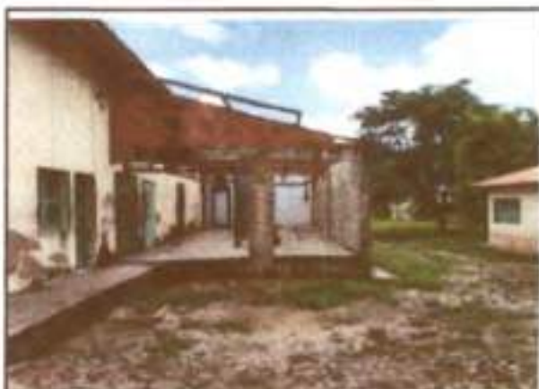
FOTO Nº VISTA CONSTRUÇÃO CÂMARA FRIGORÍFICA 5
