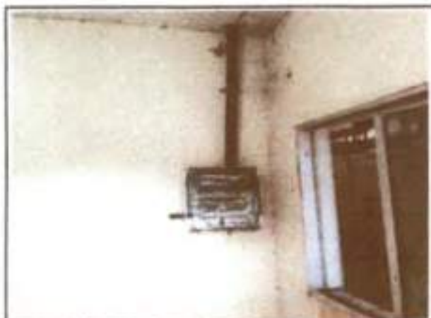
FOTO Nº VISTA QGBT SALA VETERINARIO 9
