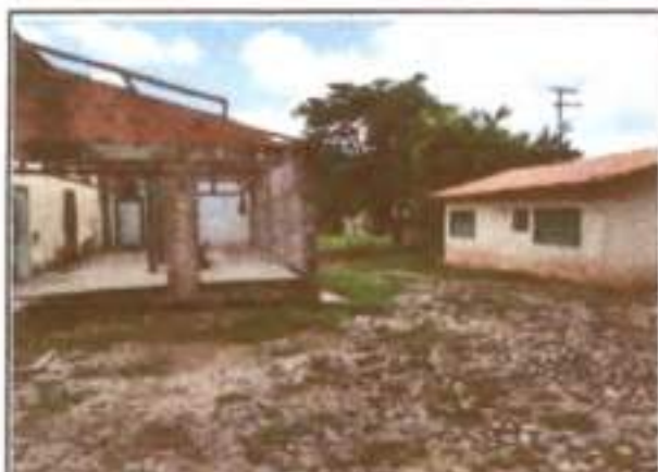
FOTO Nº VISTA CONSTRUÇÃO CÂMARA FRIGORÍFICA 5
