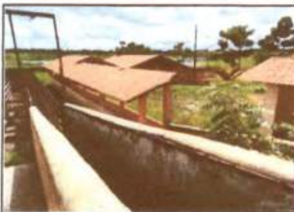
FOTO Nº RAMPA DE MATANÇA 23
