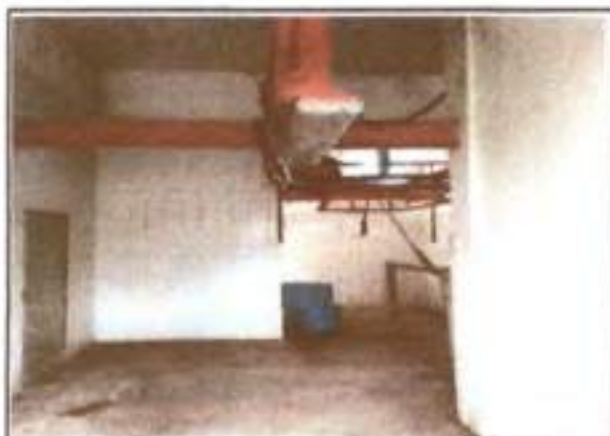
FOTO Nº VISTA ENTRADA EXPEDIÇÃO 11 PISO CIMENTADO
