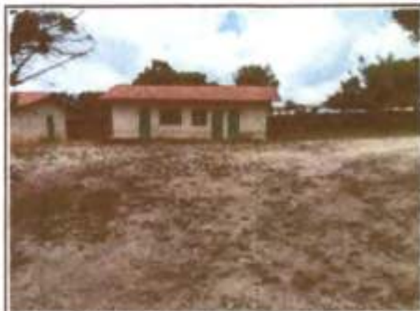
FOTO Nº VISTA VESTIÁRIO E SANITÁRIOS 4
