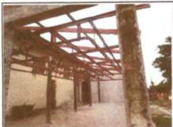
FOTO Nº VISTA CONSTRUÇÃO DA CÂMARA 7 SEM COBERTURA
