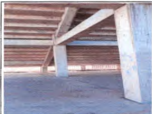
FOTO Nº 5 VISTA INTERNA PRINCIPAL
