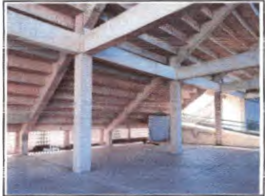
FOTO Nº 2 VISTA INTERNA, PISO ARQUIVO ENTRADA PRINCIPAL
