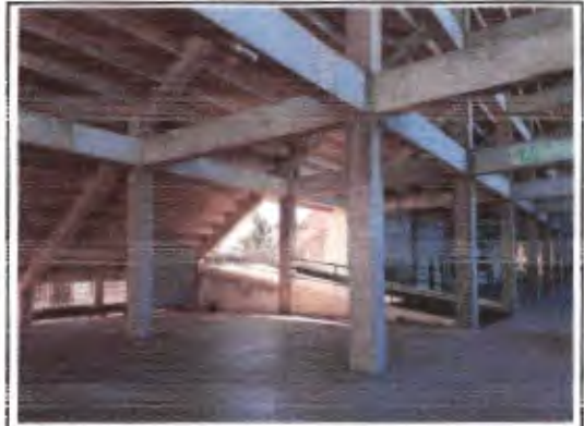
FOTO Nº 4 VISTA LATERAL DA ESTRUTURA
