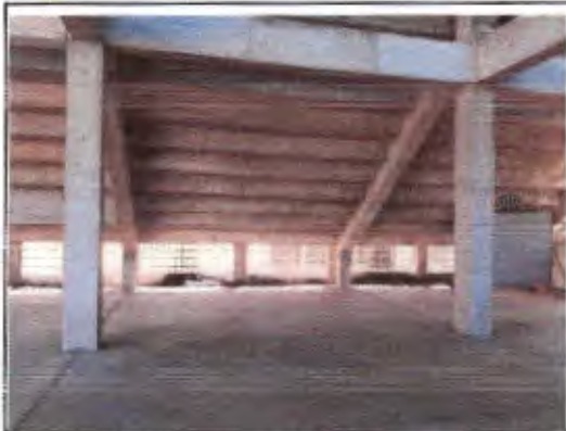
FOTO Nº 1 VISTA INTERNA, PISO ARQUIVO ENTRADA PRINCIPAL
