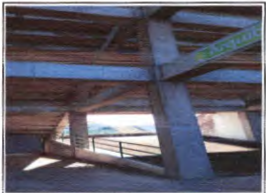
FOTO Nº 6 VISTA LATERAL DO IMÓVEL
