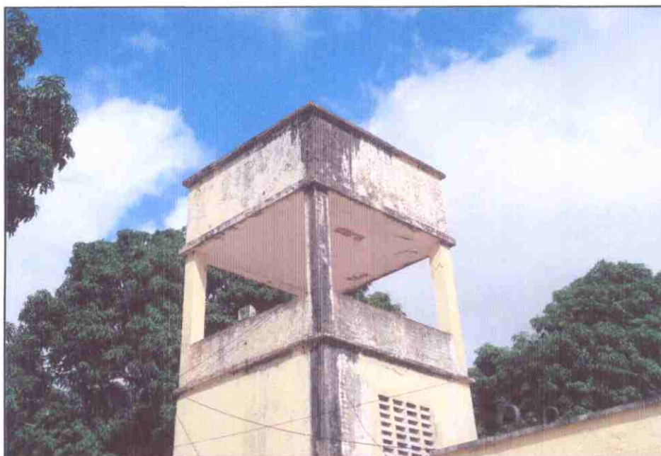
FOTO Nº EDÍCULA DA CAIXA D'ÁGUA 1 HORIZONTE-CE
