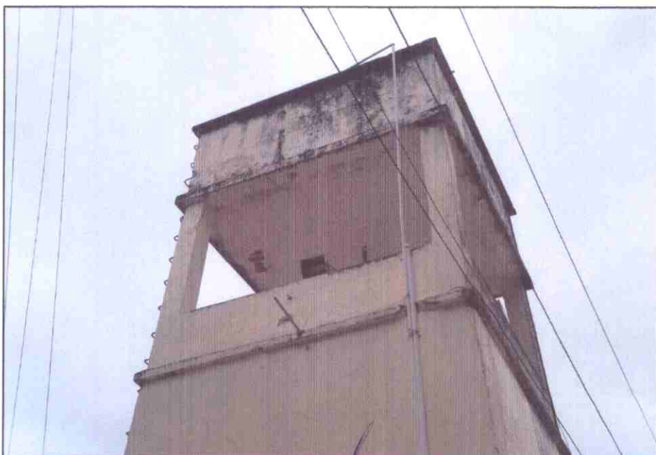
FOTO Nº EDÍCULA DA CAIXA D'ÁGUA 2 HORIZONTE-CE
