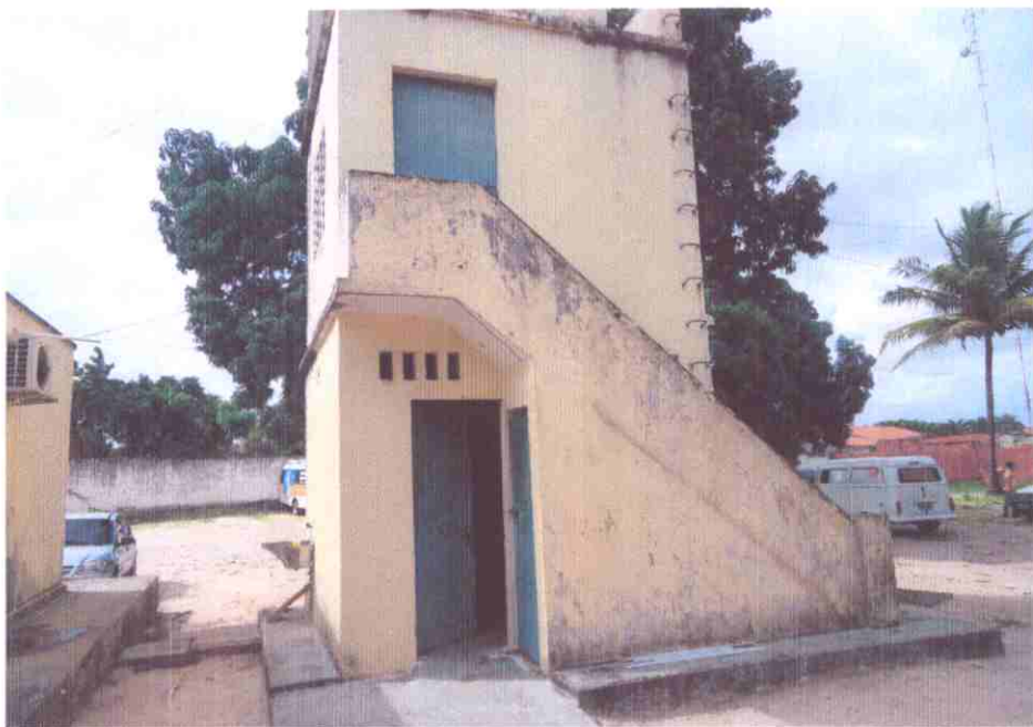
FOTO Nº FACHADA LATERAL 5 HORIZONTE-CE
