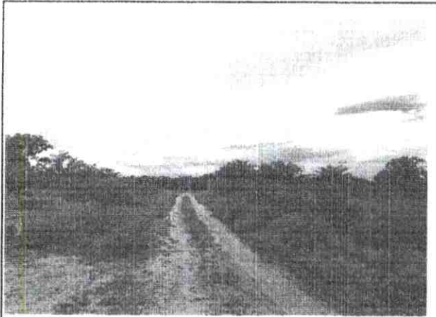
FOTO Nº RUA JOSÉ DE SOUSA 1 BAIRRO BUENOS AIRES
