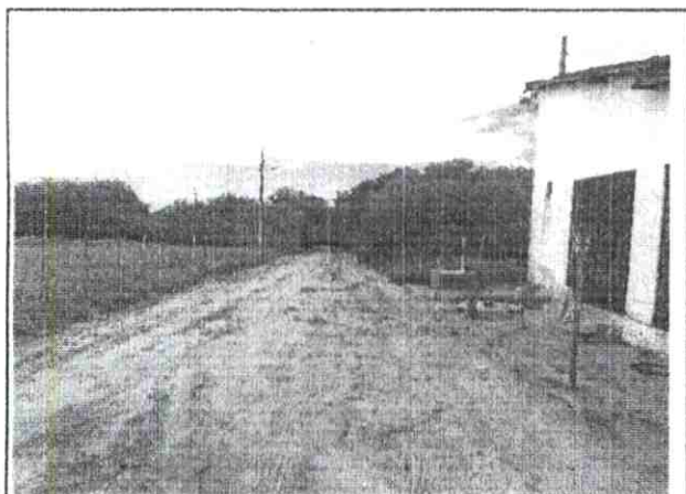
FOTO Nº RUA JOÃO ENOQUE 3 BAIRRO BUENOS AIRES
