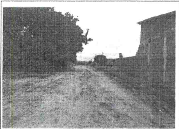
FOTO Nº RUA JOÃO ENOQUE 1 BAIRRO BUENOS AIRES
