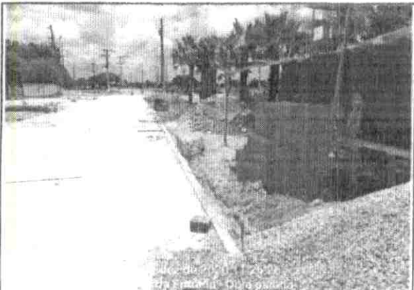
FOTO Nº PRAÇA DA ENTRADA 3 MEIO FIO CONCLUÍDO
