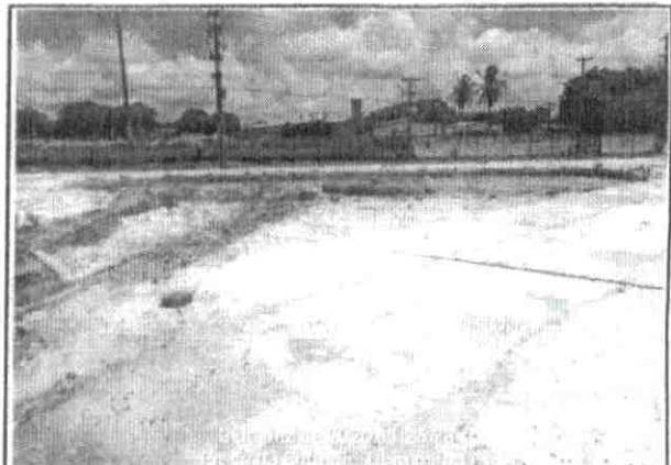
FOTO Nº PRAÇA DA ENTRADA 4 PISO EM CONCRETO EXECUTADO
