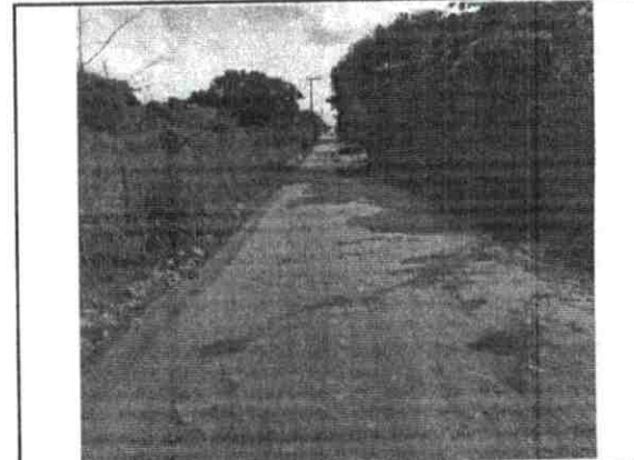
FOTO Nº RUA MANOEL VICENTE NETO 28 LAT: 4° 6'49.15"S / LONG: 38°26'5.56"O
