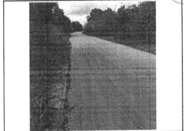
FOTO Nº AV. EZEQUIEL PINHEIRO 2 LAT: 4° 5'42.06"S / LONG: 38°24'38.78"O
