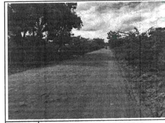
FOTO Nº RUA MANOEL VICENTE NETO 24 LAT: 4° 6'31.36"S / LONG: 38°25'54.93"O
