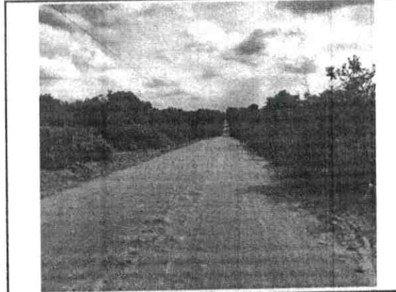
FOTO Nº RUA MANOEL VICENTE NETO 26 LAT: 4° 6'41.58"S / LONG: 38°26'2.31"O
