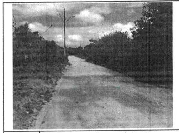
FOTO Nº RUA ANTÔNIO JOSÉ DE LIMA 18 LAT: 4° 6'33.25"S / LONG: 38°24'46.52"O
