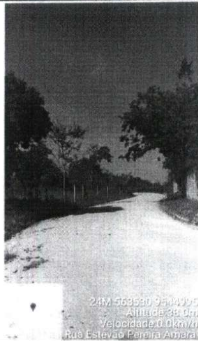
FOTO Nº RUA ESTEVAM PEREIRA - CANAVIEIRA DOS MUNIZ 34 MUNICÍPIO DE HORIZONTE-CE
