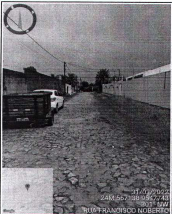
FOTO Nº PAVIMENTAÇÃO EXISTENTE 11 DIADEMA
