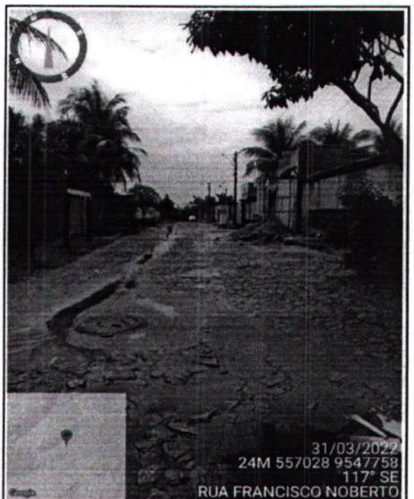
FOTO Nº PAVIMENTAÇÃO EXISTENTE 12 DIADEMA
