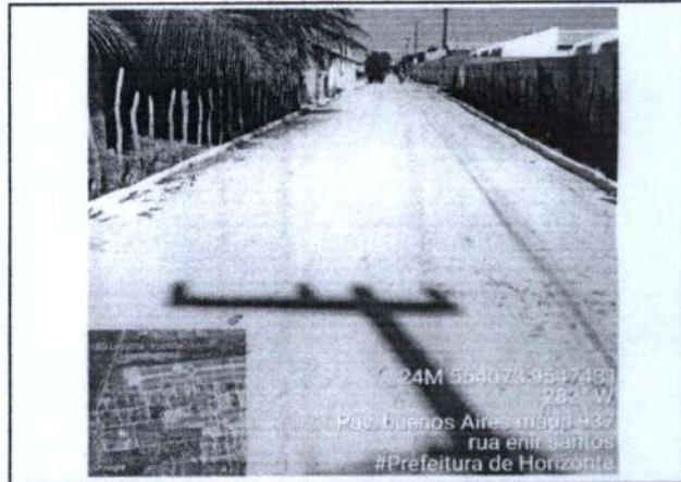
FOTO Nº RUA ENIR SANTOS 16 BAIRRO BUENOS AIRES
