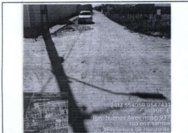
FOTO Nº RUA ENIR SANTOS 15 BAIRRO BUENOS AIRES
