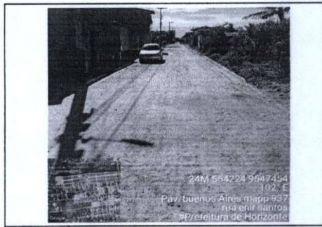
FOTO Nº RUA ENIR SANTOS 18 BAIRRO BUENOS AIRES
