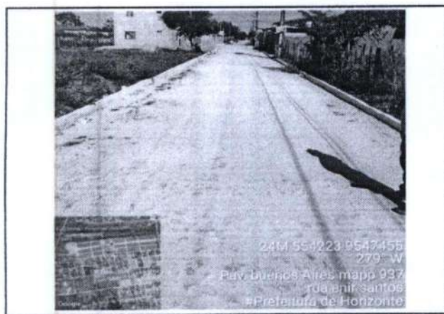
FOTO Nº RUA ENIR SANTOS 17 BAIRRO BUENOS AIRES
