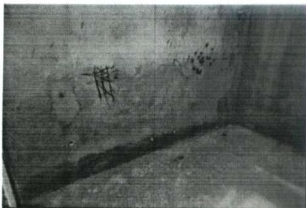
FOTO Nº PRÉDIO ADMINISTRATIVO 13 18/11/2022
