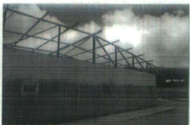
FOTO Nº PRÉDIO ADMINISTRATIVO 6 18/11/2022
