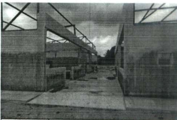
FOTO Nº PRÉDIO ADMINISTRATIVO 5 18/11/2022
