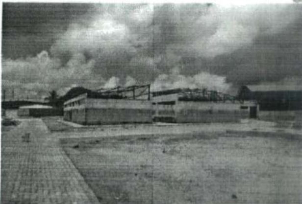
FOTO Nº PRÉDIO ADMINISTRATIVO 3 18/11/2022
