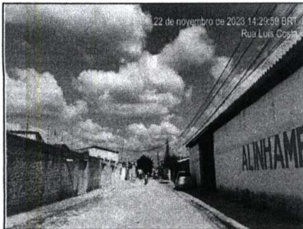
FOTO Nº RUA LUIS COSTA 57 PLANLATO HORIZONTE
