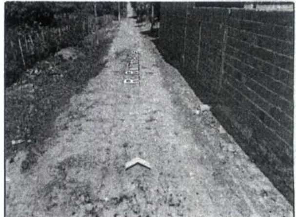
FOTO Nº RUA FIRMINO ALVES 32 ALTO DA BOA VISTA
