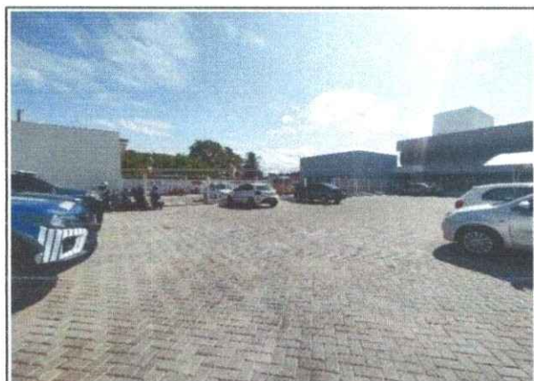
FOTO Nº CENTRO INTEGRADO DE SEG. - COBERTA 3 AGOSTO 2024
