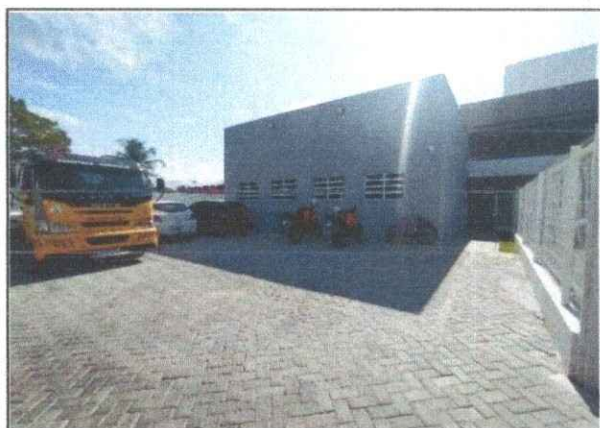
FOTO Nº CENTRO INTEGRADO DE SEG. - COBERTA 4 AGOSTO 2024
