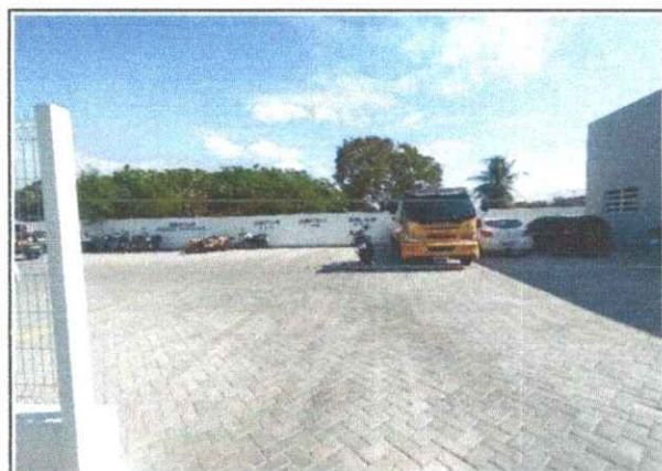
FOTO Nº CENTRO INTEGRADO DE SEG. - COBERTA 6 AGOSTO 2024
