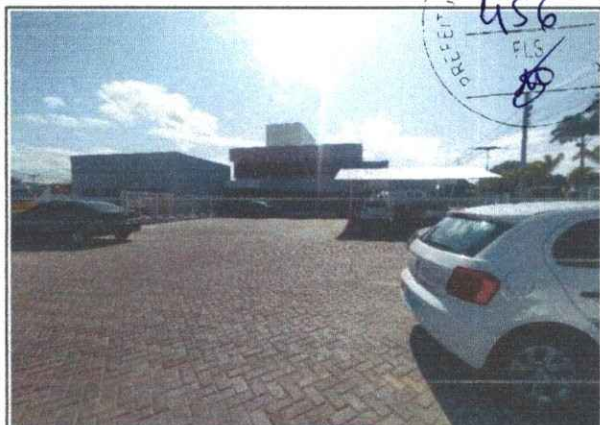
FOTO Nº CENTRO INTEGRADO DE SEG. - COBERTA 2 AGOSTO 2024
