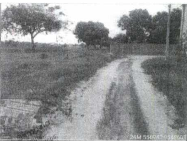
FOTO Nº 78 RUA ISIDORO CASTRO - MAL COZINHADO SETEMBRO 2025
