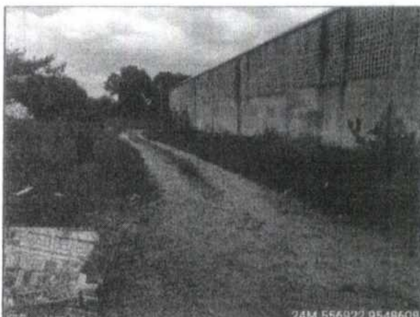
FOTO Nº 76 RUA ISIDORO CASTRO - MAL COZINHADO SETEMBRO 2025
