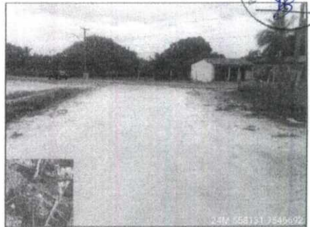
FOTO Nº RUA SANTA BERNADETE - ZUMBI
