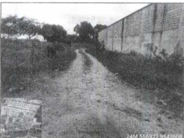
FOTO Nº 75 RUA ISIDORO CASTRO - MAL COZINHADO SETEMBRO 2025
