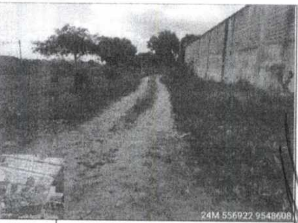
FOTO Nº 77 RUA ISIDORO CASTRO - MAL COZINHADO SETEMBRO 2025
