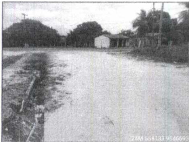
FOTO Nº RUA SANTA BERNADETE - ZUMBI
