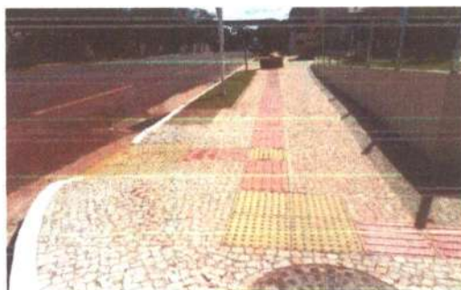
Figura 16 – Calçada modelo com piso tátil
